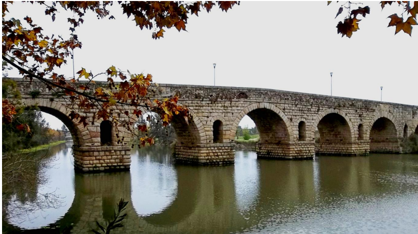
Античный мост через Гвадиану в Испании длиной в 755 метров
